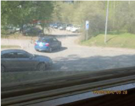
Ikkunat ovat enintään tyydyttävässä kunnossa. Suositellaan uusimista.
