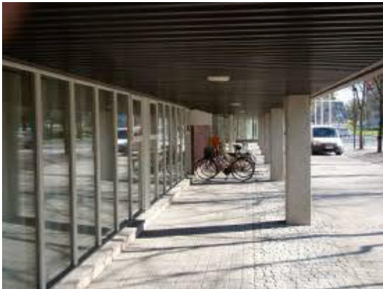
Ulkovalaisimia suojan alla.
