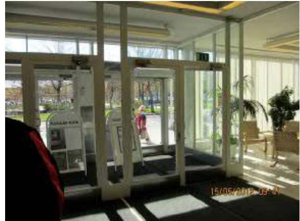
Pääoven ympärillä olevia ikkunoita..
