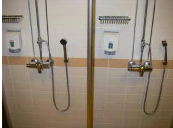
Saunan suihkut ovat uusia.
