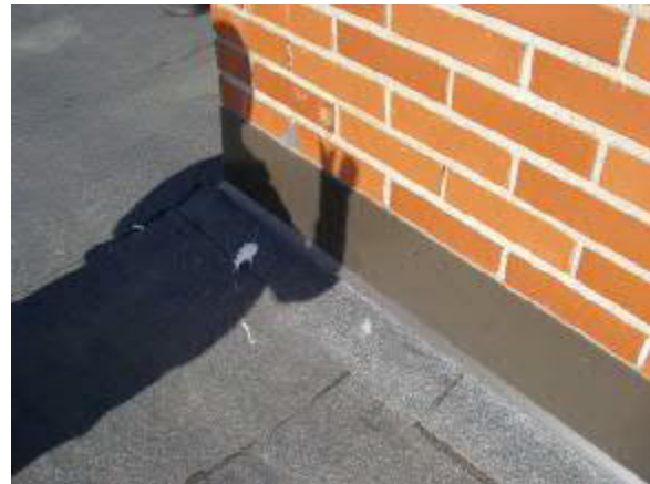
Listoituskohdat ovat mahdollisia vuotokohtia.
