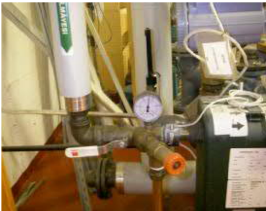
Veden paine on nähtävillä siirrinpaketilla.
