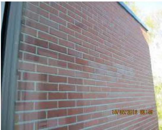
Tiilipintaiset julkisivupinnat olivat silmämääräisesti tyydyttävässä kunnossa...
